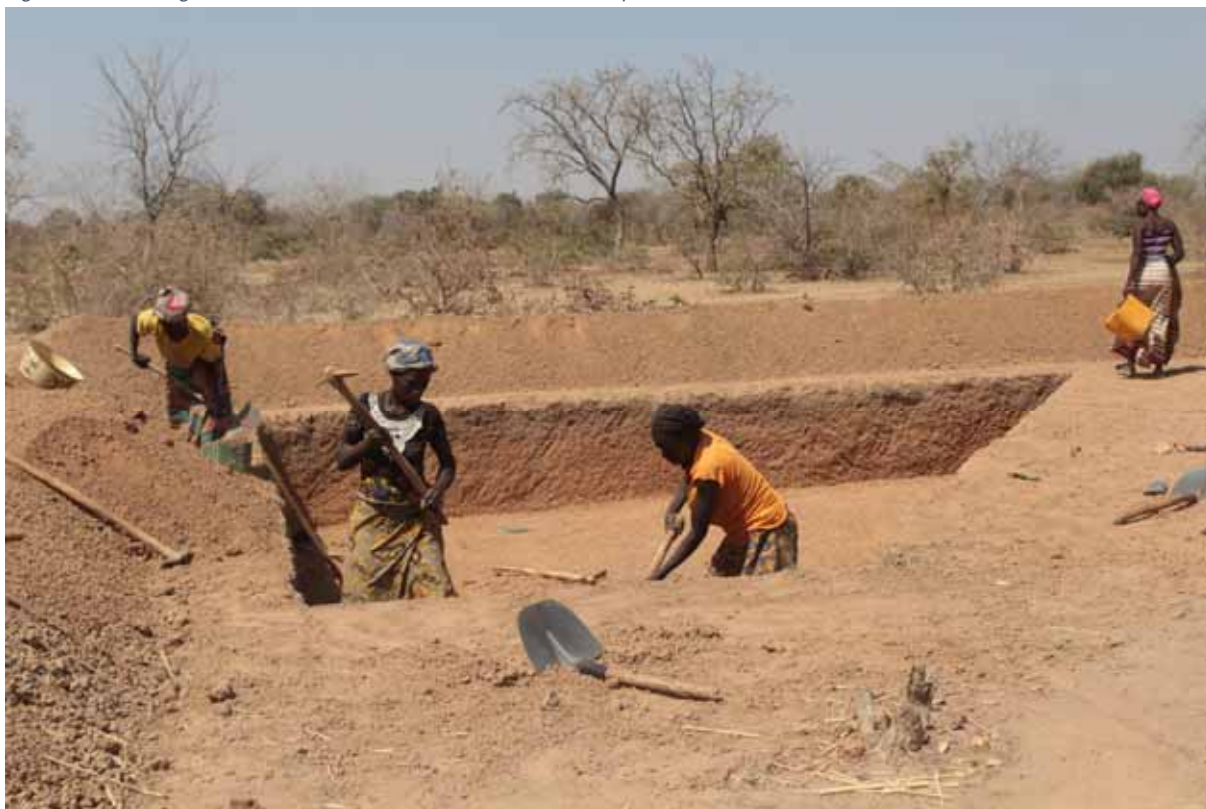
Figure 32 : Creusage d'une mare d'infiltration dans un nouveau périmètre
